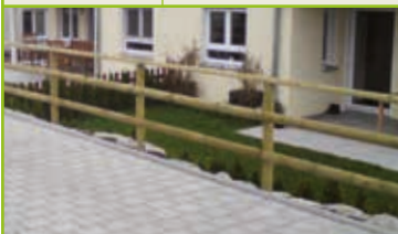
Pfähle KDI* zylindrisch gefräst, Kopfende gefast
