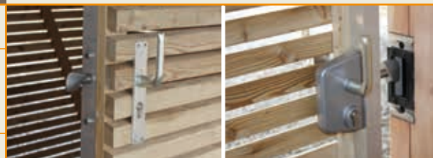
Türgriff mit Schiebetüren-Schloßkasten Vorder- & Rückansicht
