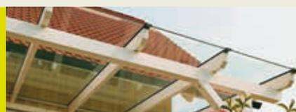
Um den konstruktiven Holzschutz der Balken zu gewährleisten empfehlen wir, neben einem deckenden Erstanstrich, eine umlaufende Blechverwahrung und Dachrinne anzubringen.
