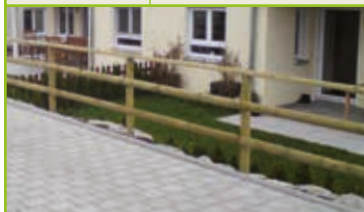
Pfähle KDI* zylindrisch gefräst, Kopfende gefast
