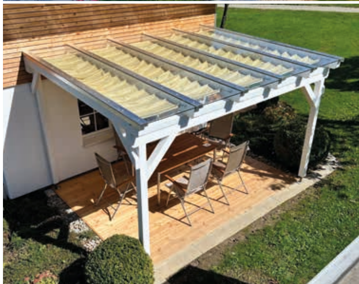
^ Pergolaüberdachung mit Terrassendielen aus Douglasie
