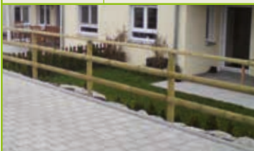
Pfähle KDI* zylindrisch gefräst, Kopfende gefast
